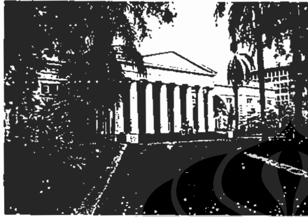
Foto 46. Tampak muka dari bangunan Museum Seni Rupa.
